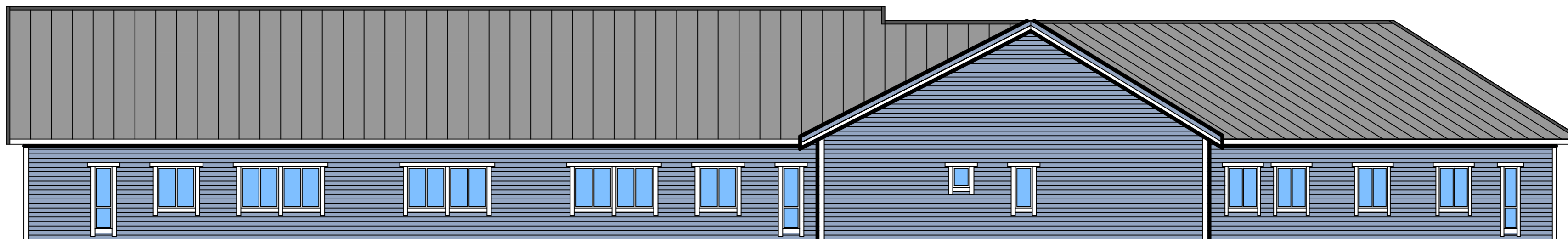
Fasade mot nordvest
