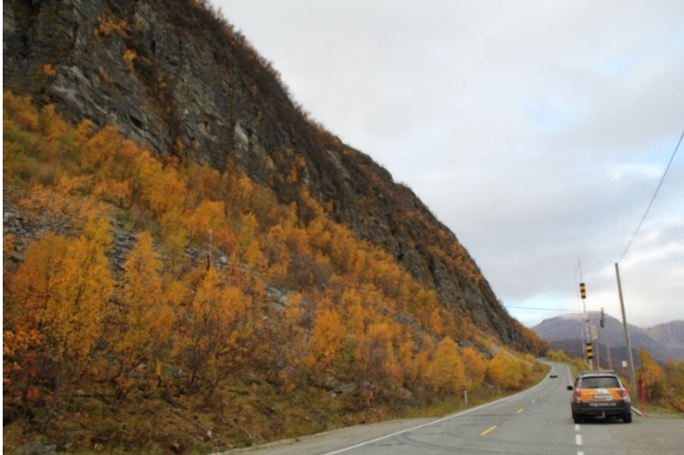
Figur 12) Foto: E6 gjennom Rakkenesura, med østre bom for Kvænangsfjellet Foto: O. A. Helgaas
