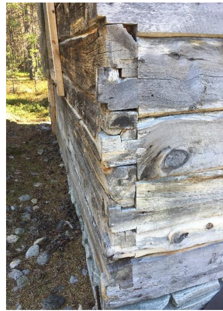
Kamlafting er kjent fra hele landet i tillegg til svensk og finsk side av Tornedalen. Den ble først tatt i bruk på 1700-tallet og var da særlig brukt i kirkebygg før den på 1800-tallet ble tatt i bruk i våningshus. Foto: L. Brekmoe
