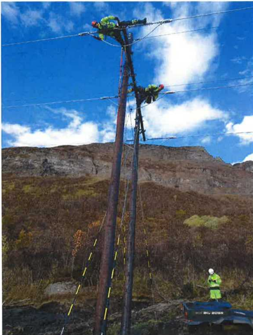
Montører i arbeid. Foto: Morten Bersvendsen
