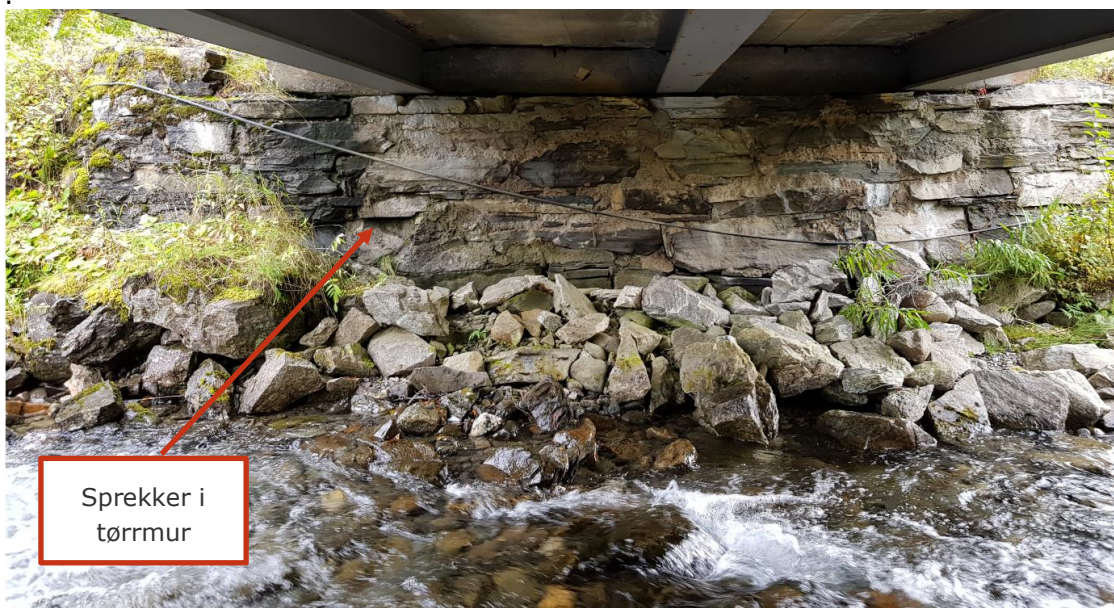
Figur 5 Tilstand på østlige landkar (landkar mot Kvæangsfjellet).
