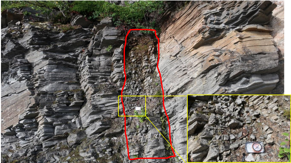
Figur 25: Ved Buktasvingene ble det observert en sone med sterk oppsprekking, i forhold til omkringliggende bergmasse. Sonen har orientering parallelt med sprekesett S1.
