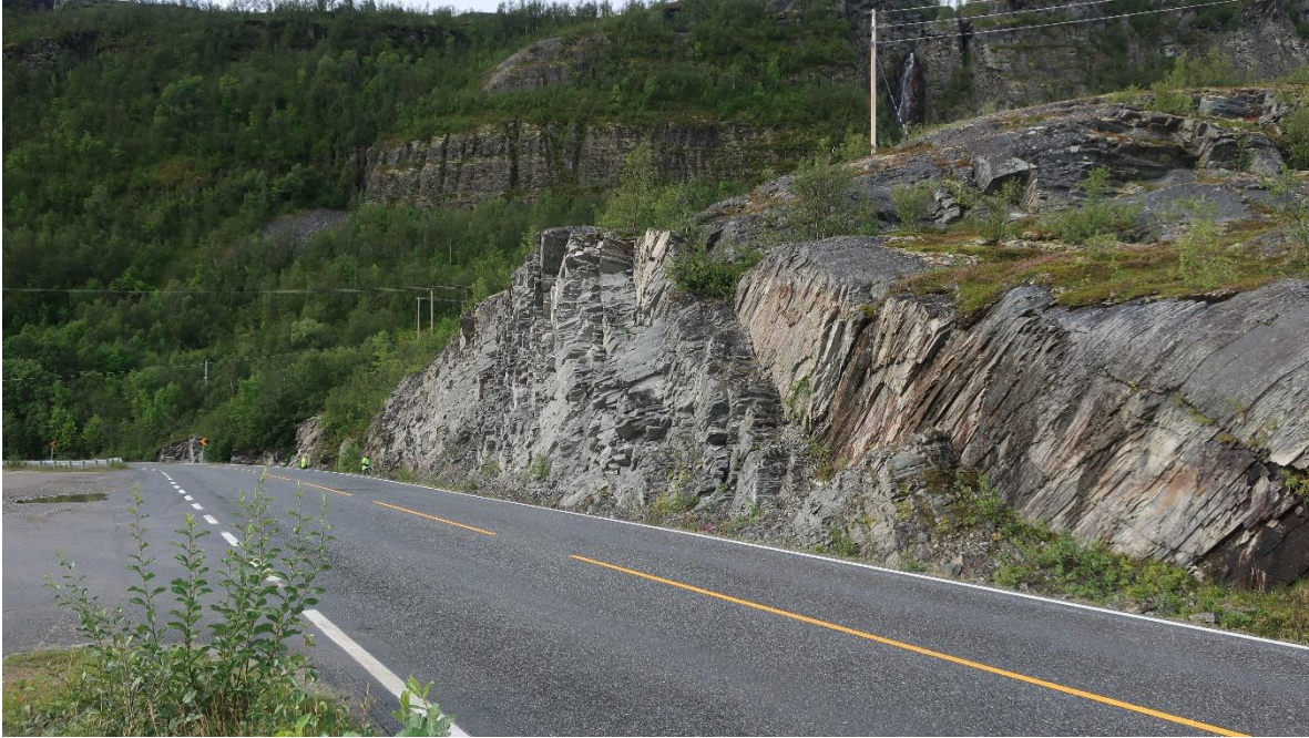
Figur 19: Eksisterende bergskjæring mot profil 22450.
