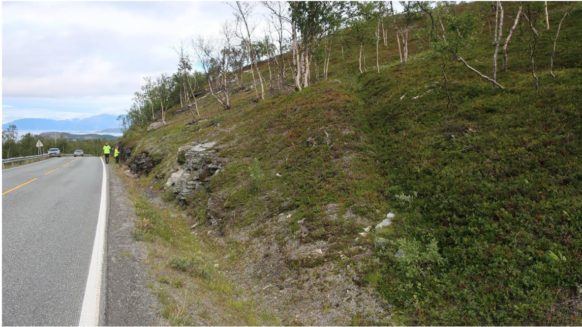
Figur 7: Eksisterende bergskjæring ved profil 16150 og sprekkekartlegging.
