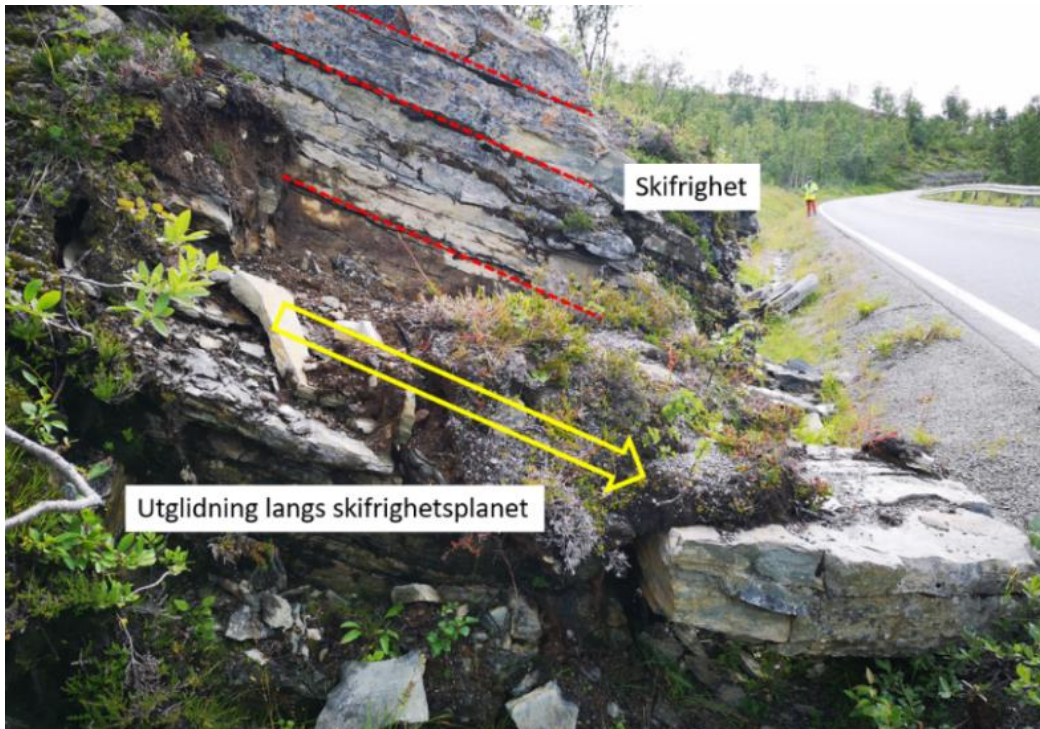
Figur 16: Utglidning av blokker langs skifrihetsplanet ved ca. profilnummer 16200. Blokk på omtrent 0,3 m 3 fanget opp av vegggrøft.
