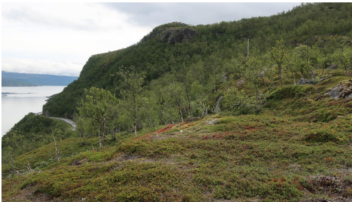
Figur 12: Foto fra overside av eksisterende bergskjæring ved profil 17250.
