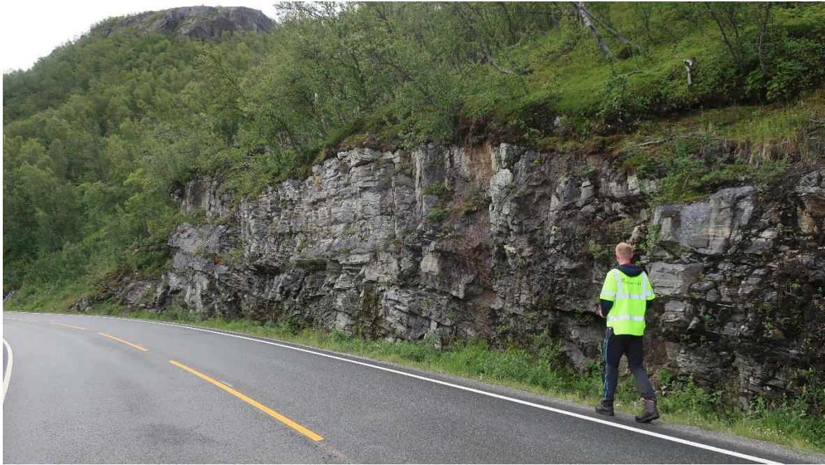
Figur 13: Eksisterende bergskjæring ved profil 17350 og sprekkekartlegging.
