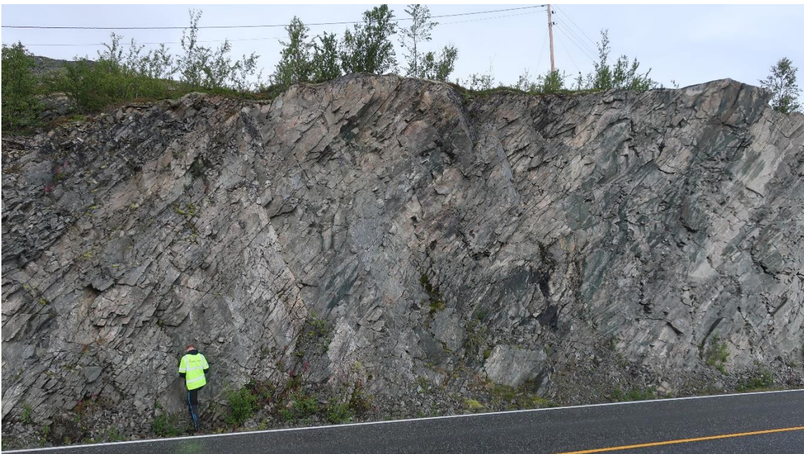
Figur 20: Eksisterende bergskjæring ved profil 22450 og sprekkekartlegging.
