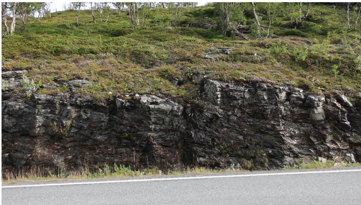
Figur 9: Eksisterende bergskjæring ved profil 16200.
