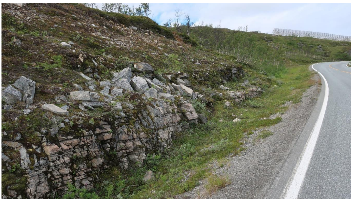
Figur 2: Eksisterende bergskjæring ved profil 14790.
