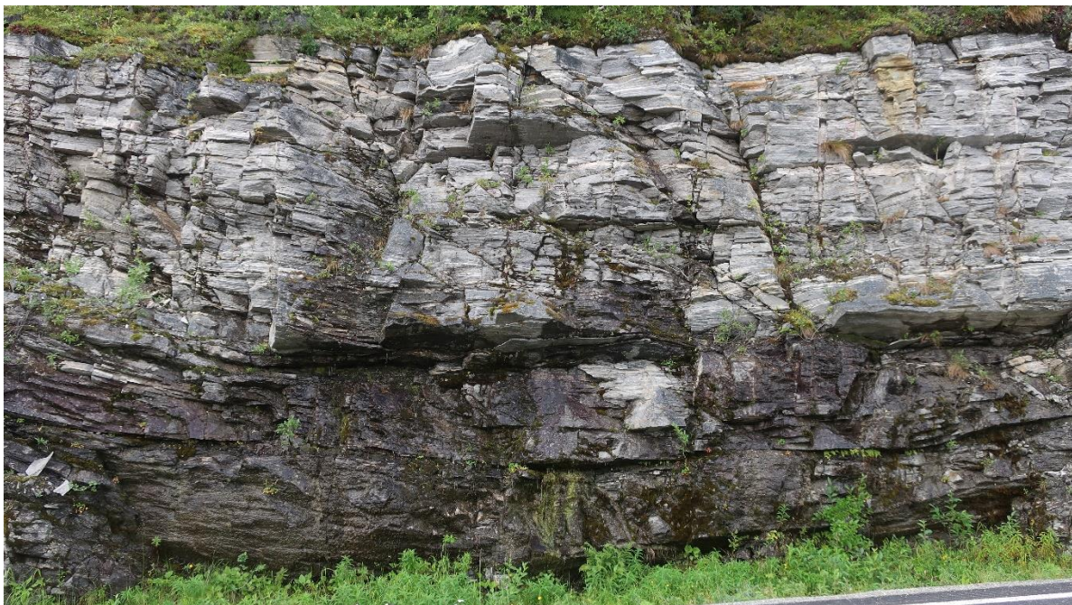
Figur 14: Eksisterende bergskjæring ved profil 17350.
