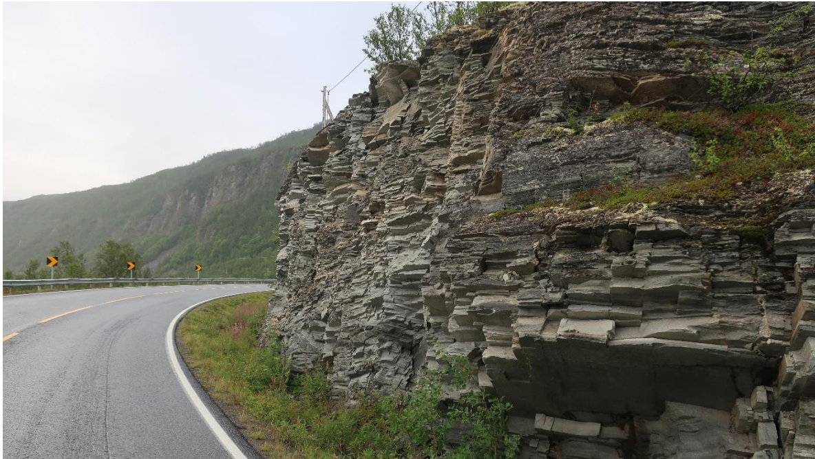
Figur 17: Eksisterende bergskjæring ved profil 22350 med tydelig skifrihet og moderat til sterk oppsprekking.
