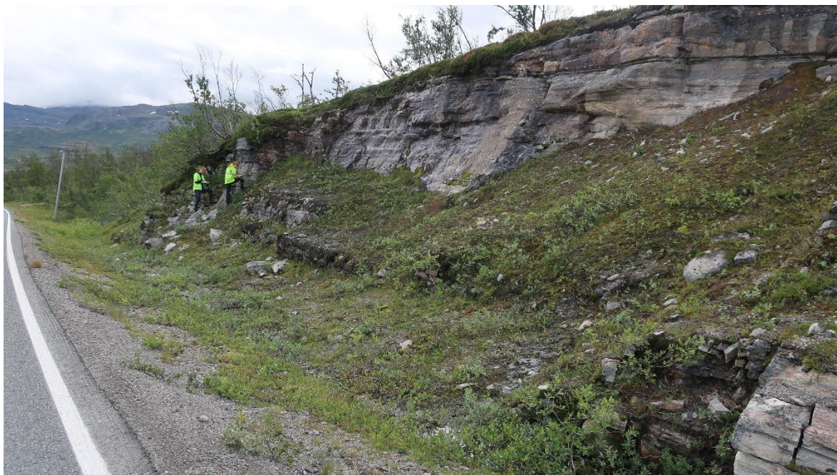
Figur 5: Eksisterende bergskjæring ved profil 14830 og sprekkekartlegging.
