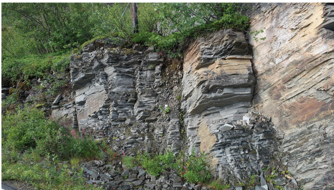
Figur 16: Eksisterende bergskjæring ved profil 22300 med sterkt oppsprukket sone parallelt med S1.
