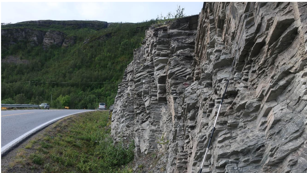
Figur 18: Eksisterende bergskjæring ved profil 22400 med tydelig skifrihet og moderat oppsprekking.
