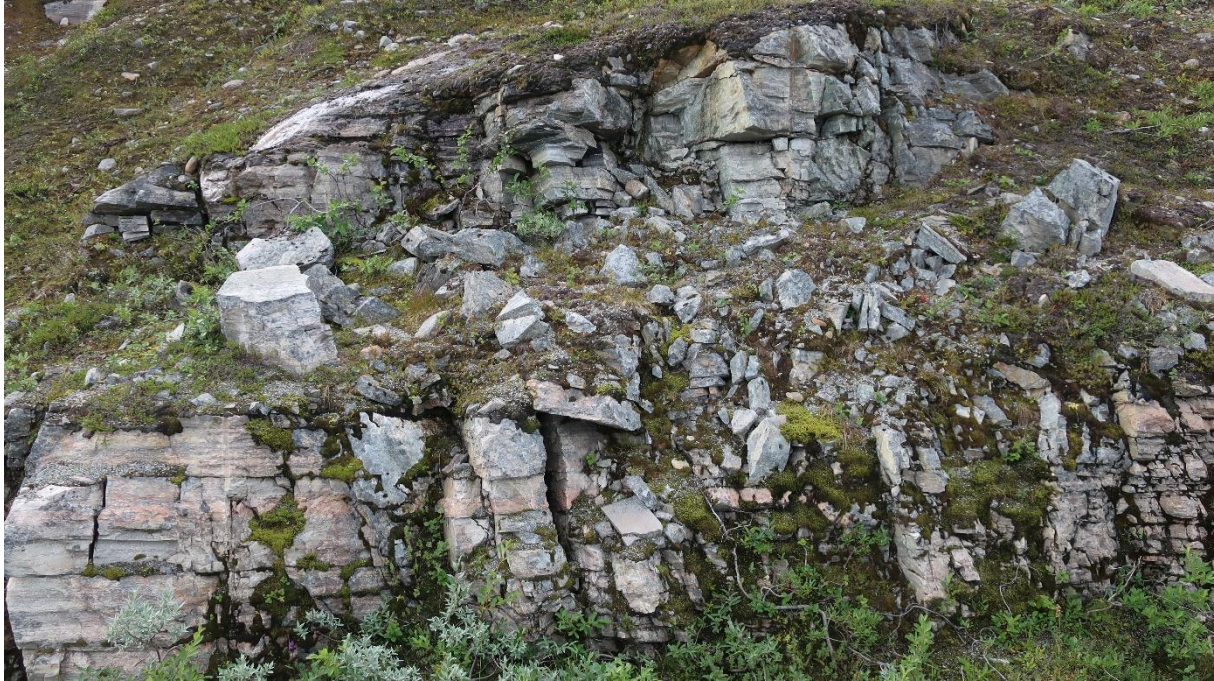
Figur 3: Eksisterende bergskjæring ved profil 14800.
