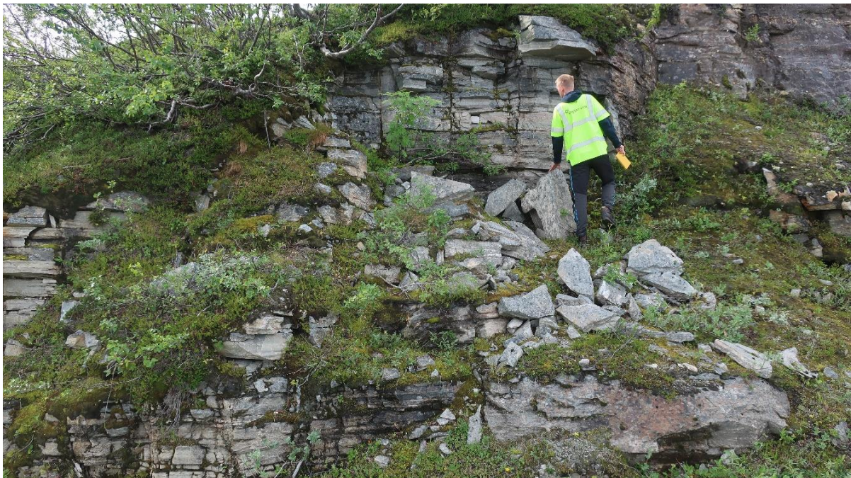
Figur 4: Eksisterende bergskjæring ved profil 14830 og sprekkekartlegging.
