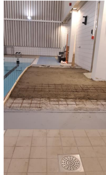
Klargjøring før legging av fliser rullestolrampe basseng.
