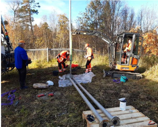
Utskifting av grunnvannspumper Burfjord vannverk.
